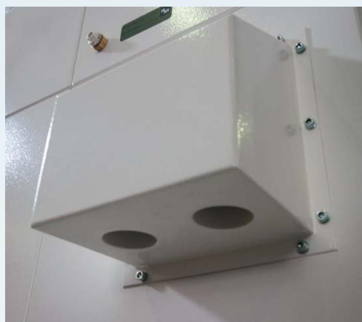
Caixa de aspiração versão 1, 2 x DN 50 mm
